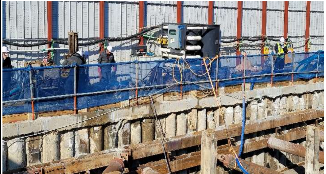
오탁수 처리 방류현장 (속초 호텔 현장)
