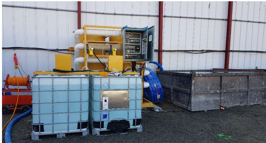
오탁수 처리 방류현장 (강원도 빌딩 신축 현장)
