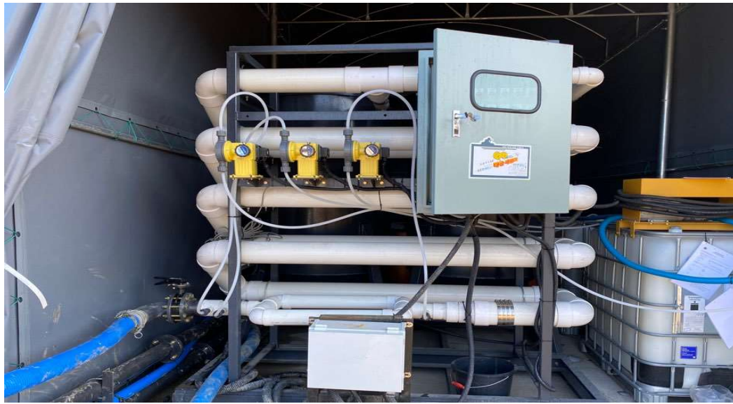
세륜수 리사이클링 시스템 (당진 화력 현장)
